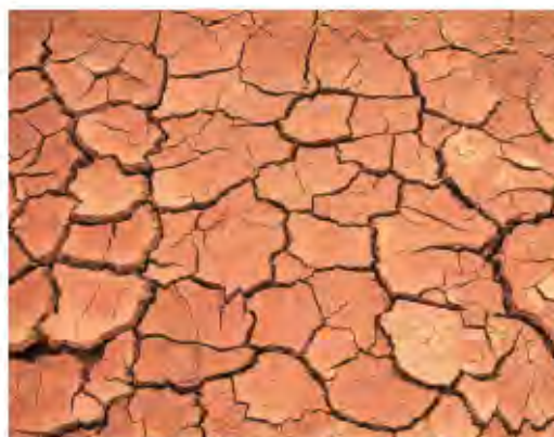
Fentes de dessiccation sur un sol argileux. Sources : BRGM
