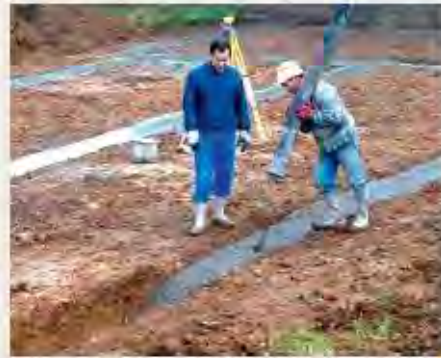
Coulage de fondations d'une habitation sur sols argileux. Source : AQC
