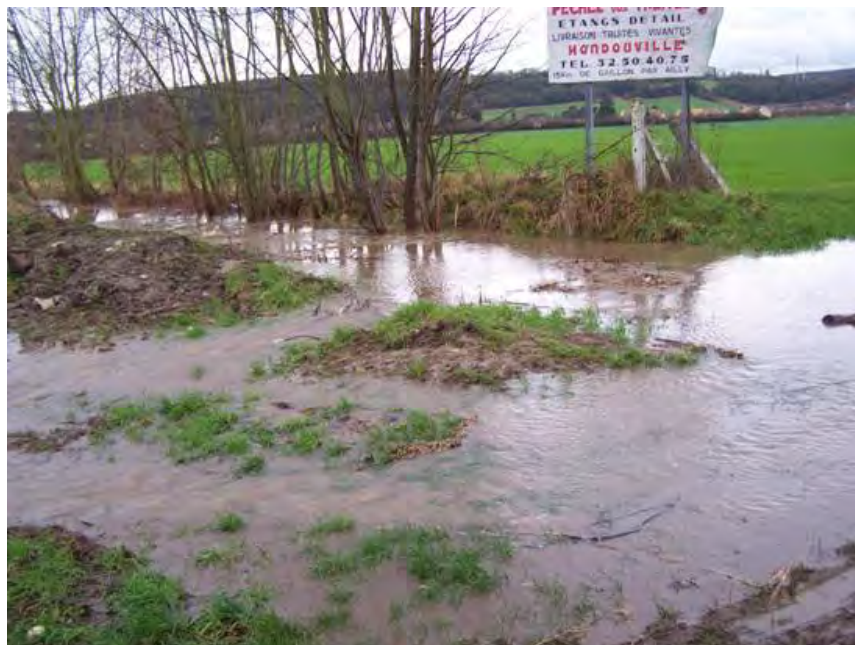
Figure 3 : Inondation en amont de l'ouvrage OH-5-J fin février 2007
