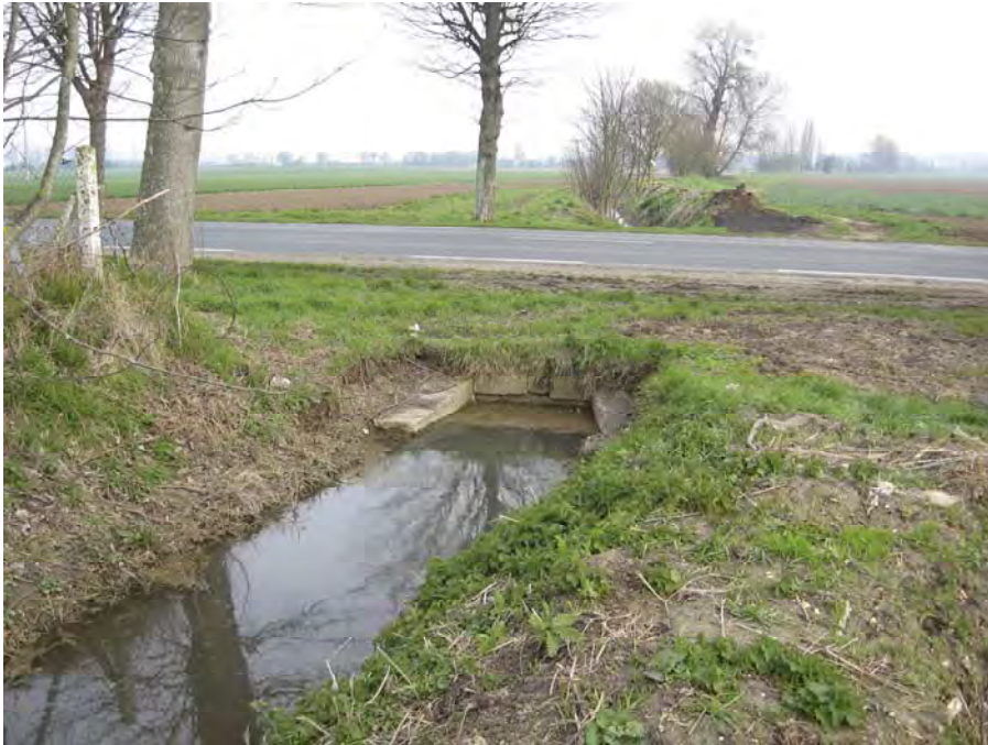
Figure 2 : L'ouvrage de franchissement de la RD6015 le 23 mars 2007. L'ouvrage était bouché ce jour-là, ce qui explique qu'il soit noyé en amont malgré le faible écoulement
