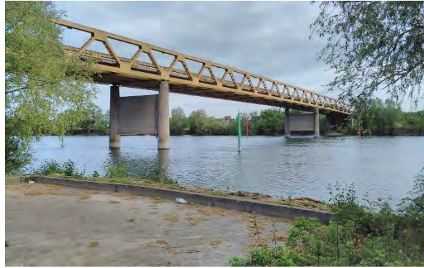
Figure 53 : le pont Aubevoye-Courcelles
