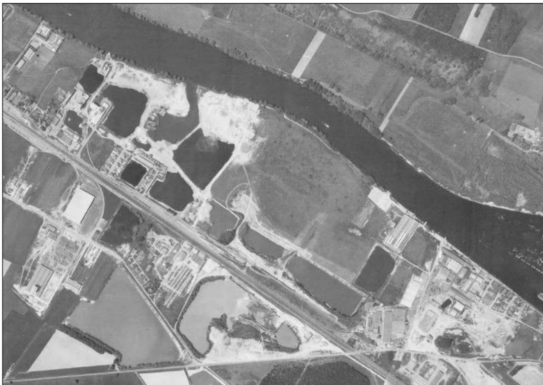
Photographie aérienne de la zone des Trente Acres en 1973 (source : Géoportail)
